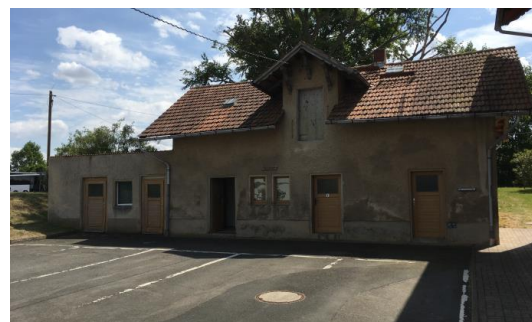
städtisches Sanitärgebäude am Schlossvorplatz
