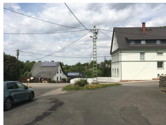
Platzfläche Schlossvorplatz vor dem Sanitärgebäude
