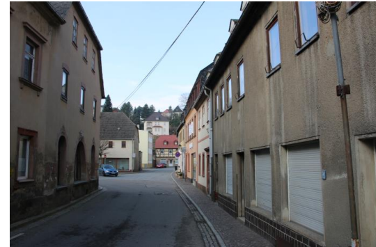
Blick von der Muldenbrücke zum Markt
