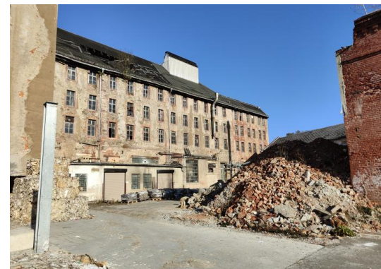
hinteres Produktionsgebäude (Teilabbruch geplant)
