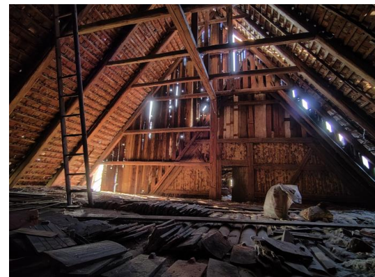
Dachstuhl im Nebengebäude (Scheune)
