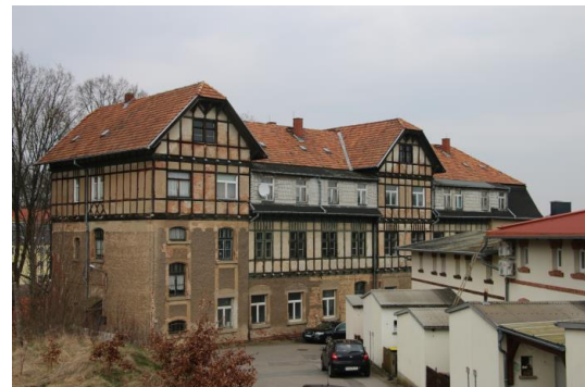
Heinrich-Heine-Straße 29-33 (ehem. Mädchenheim)
